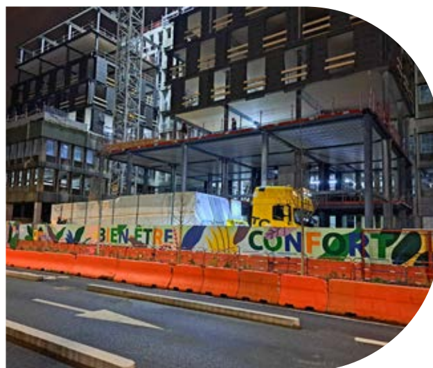
Livraison de matériaux de nuit sur un chantier de la Part-Dieu - Lyon 3 e
