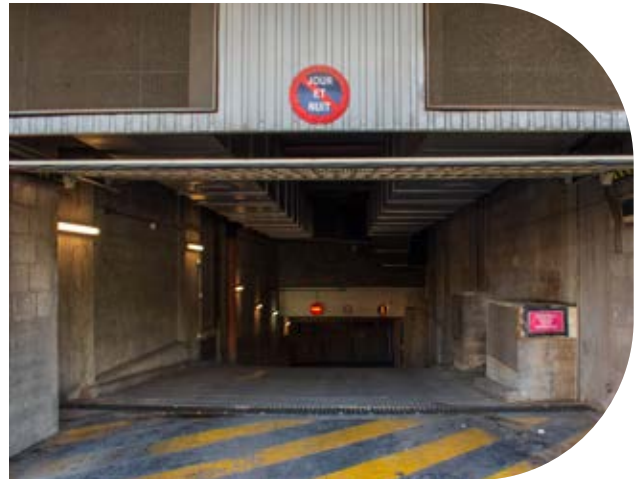
Entrée de parking souterrain d'un immeuble privé - Lyon 3e
