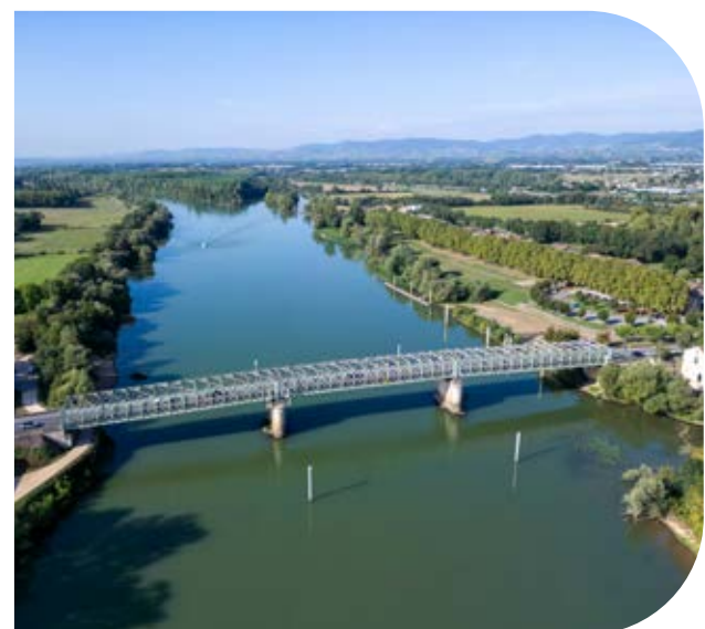
Pont routier entre Belleville-en-Beaujolais et l’Ain
