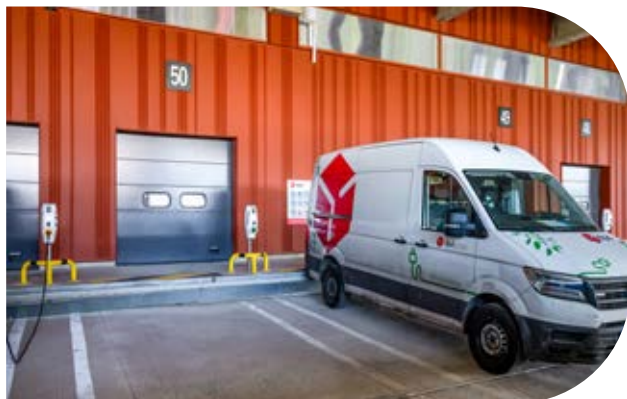
Quais de chargement de l'Hôtel Logistique Urbain (HLU) - Lyon 7 e
