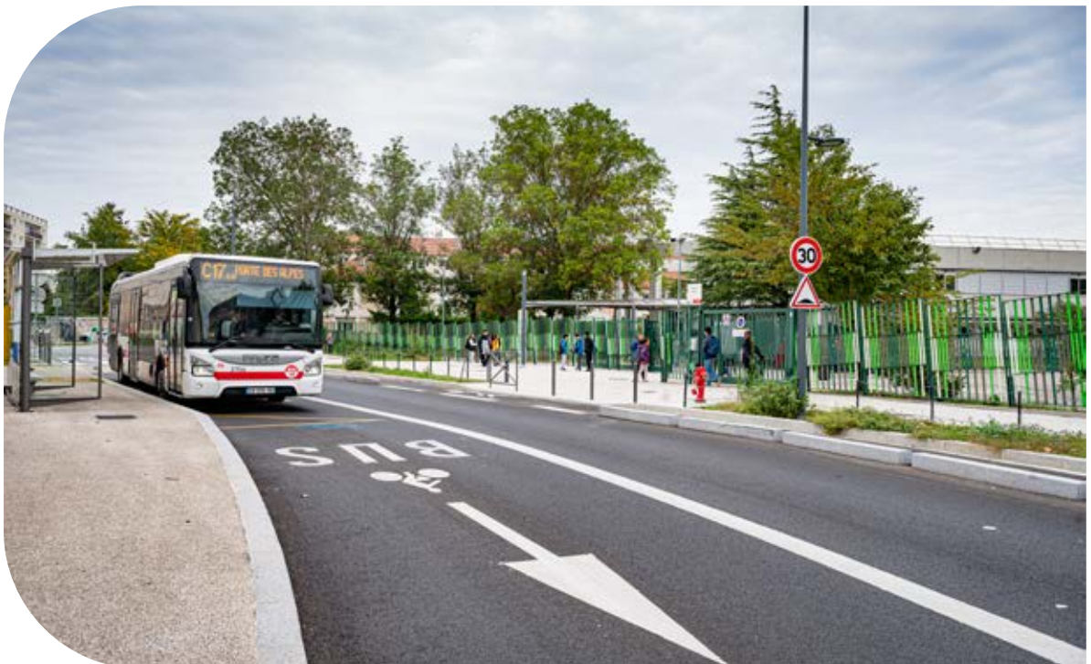
Aménagements de voirie rue du 8 mai 1945 - Villeurbanne
