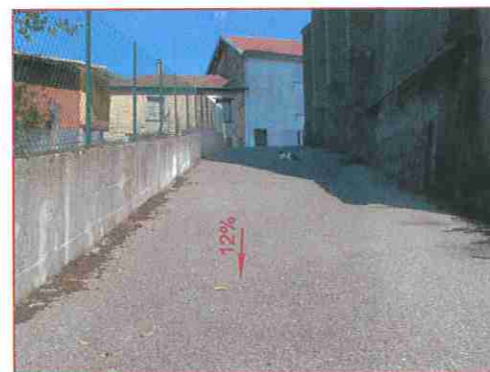
Chemin piétonnier reliant la MAPAD au centre village. Largeur moyenne 3.00m. Rampe moyenne 12%.
