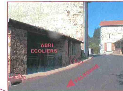
Abrigus écoliers, accès surbaissé. Trottoir largeur moyenne 0.80m. en face 0.85m.
