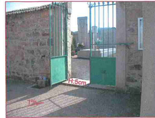
Entrée Cimetière. Seuil hauteur 5 centimètres. Rampe 7%. Portail 2 vantaux de 0,80m.
