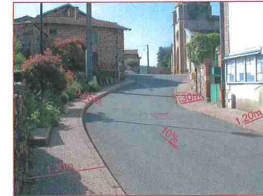
Trottoirs de largeur variable : côté gauche : 0,85m à 1,30m. côté droit : 1,20 à 1,30m.
