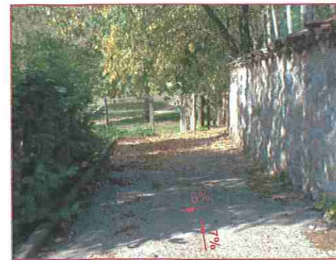
Chemin piétonnier reliant la MAPAD au centre village. Largeur moyenne 2.00 m. Rampe moyenne 7%.Devers 6%.
