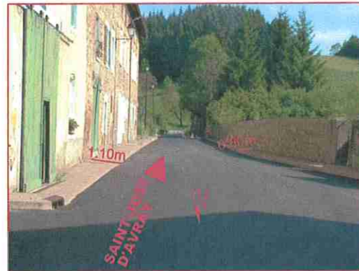
Trottoirs de largeur variable : côté gauche : 1.10m. côté droit : 0.80m.
