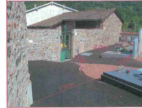
Allées Cimetière de 2,00 à 2,50m de largeur. Devers : 2% en moyenne. Rampe devant portail 14% sur 2,00m.
