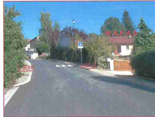
Entrée sud bourg, Accès de la Maison d'Accueil Pour Adultes Dépendants. Trottoir largeur côté droit : 0.85m. Trottoir largeur côté gauche : 0.90m.
