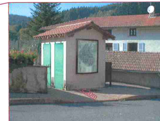
WC public, accès surbaissé. Trottoir 2,20m.
