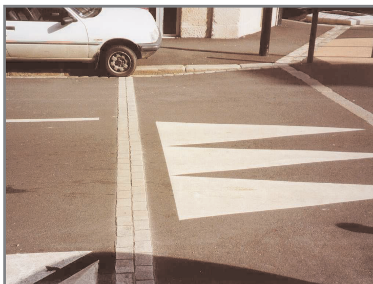
Bandes transversales en « pavés de résines » sous forte circulation
