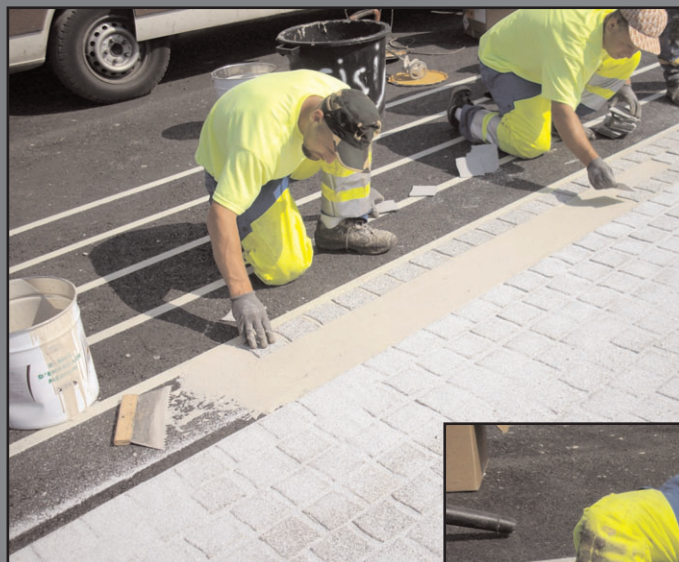
Mise en oeuvre des « pavés de résine »
