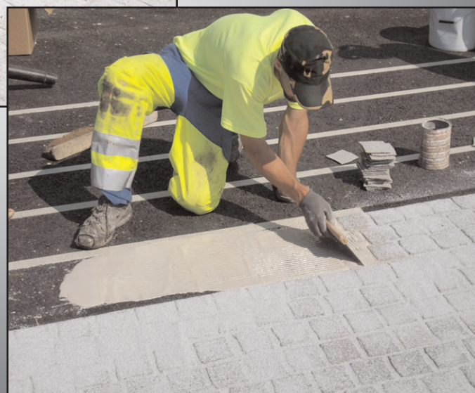
Mise en oeuvre des « pavés de résine »
