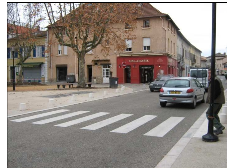
Genas – RD 29 : Mobilier mal positionné, et non détectable (ne respecte pas l'abaque, et ne possède pas de bande de détection)
