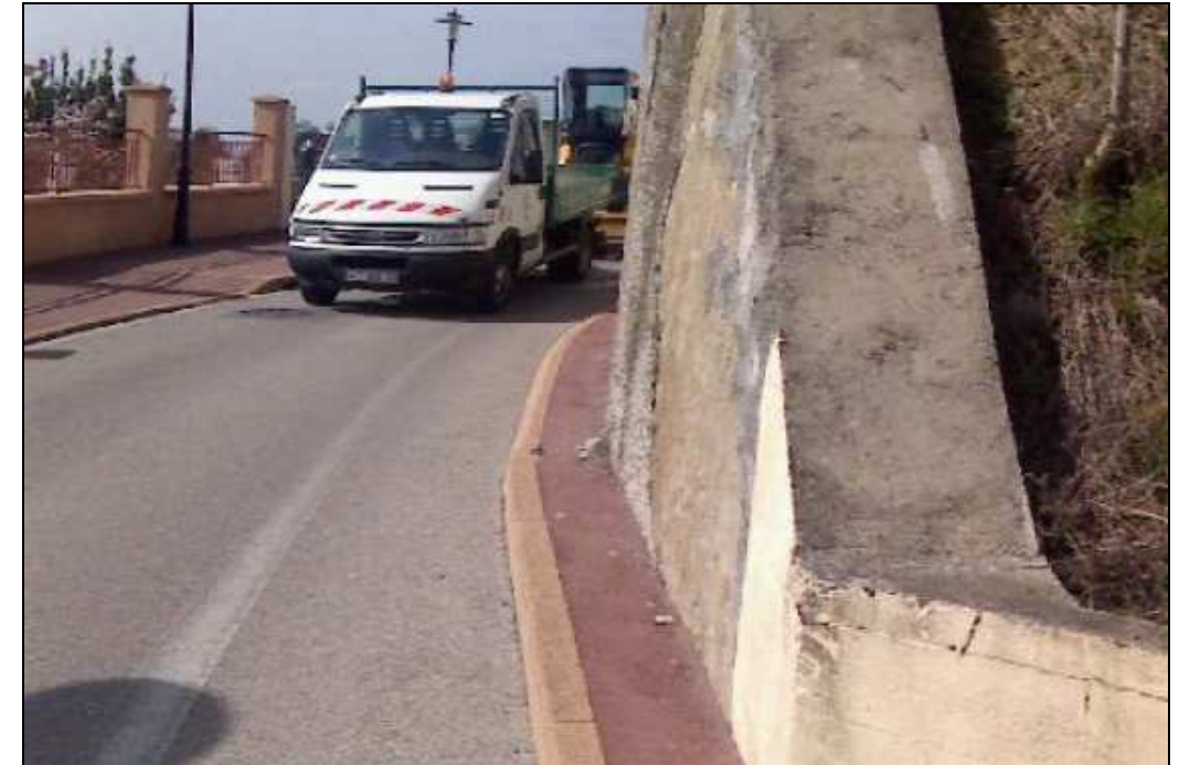
Genas – Rue de la Liberté : Impossibilité technique d'élargir les 2 trottoirs sans remettre en cause la circulation automobile/cycle : création d'une Zone 30 pour permettre de garder un seul trottoir accessible.
