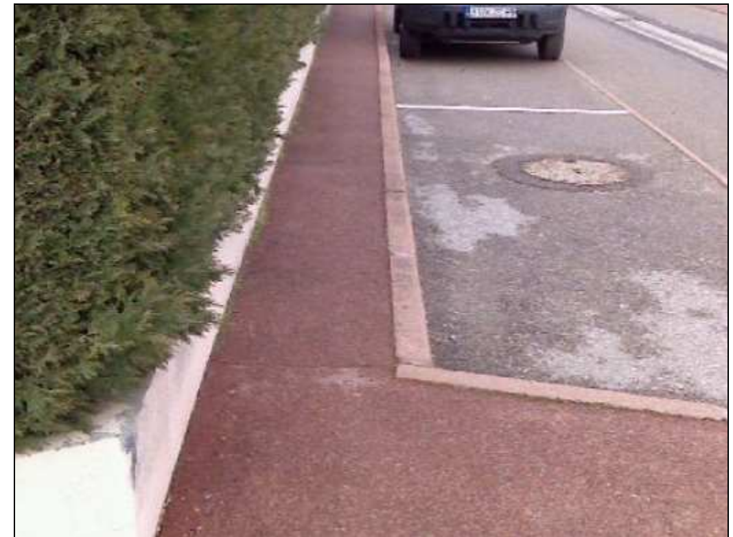
Genas – Rue de la Rivoire : Élargissement du trottoir, avec suppression du stationnement en accotement.
