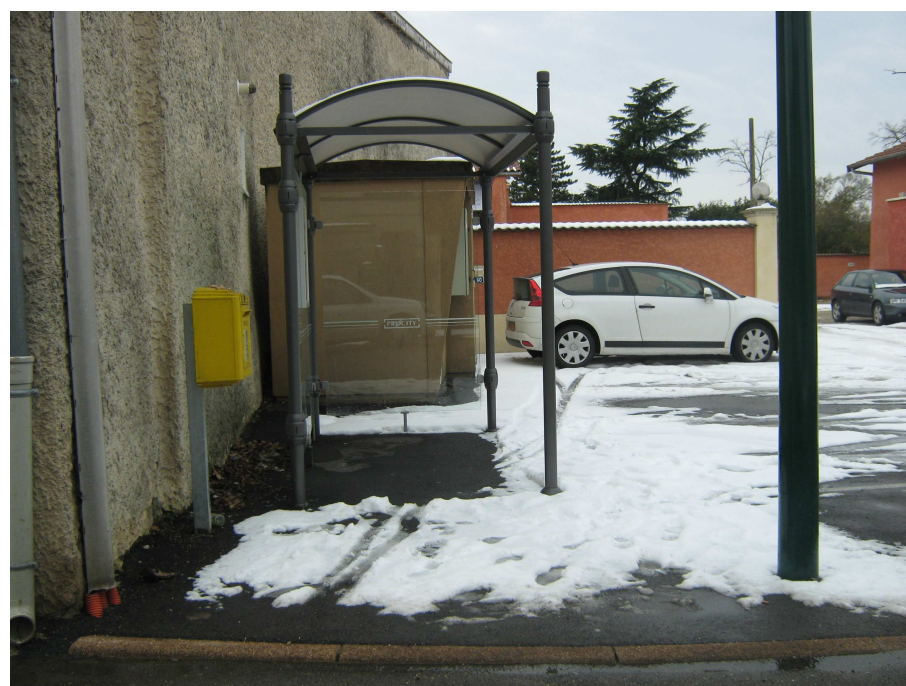
Rue de l'Egalité : arrêt de bus sans quai
