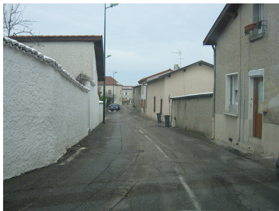
Rue de l'Egalité : absence de trottoir
