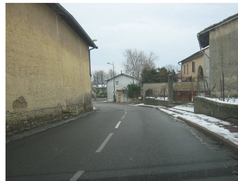
Rue de l'Egalité : trottoirs trop étroits
