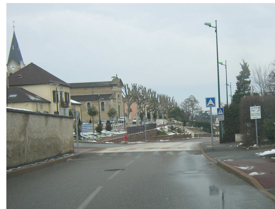
Rue de l'Egalité : pente trop forte
