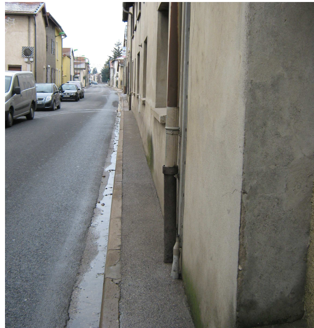
RD306 : trottoir trop étroit
