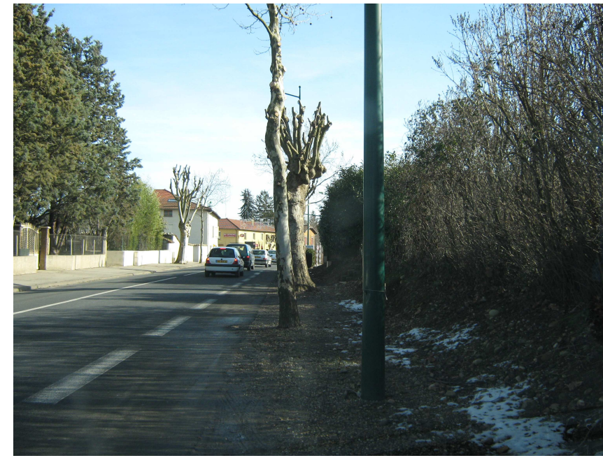
RD306 : absence de trottoir
